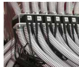
Kontrola przepływu nasion
